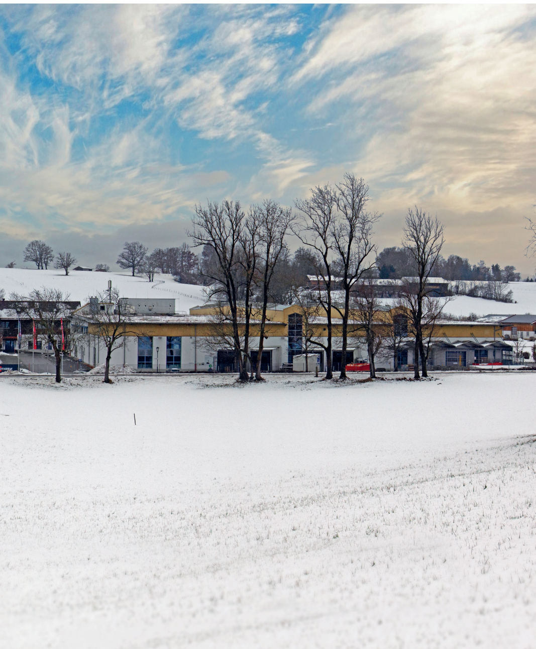
Unser Firmengelände am Rande von Eglfing, 15 Kilometer südlich von Weilheim.; kleines Bild: das zuletzt errichtete Produktionsgebäude im Bau
